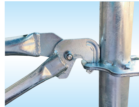
先行手すり筋交い設置
